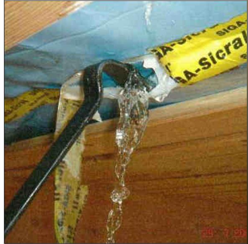
Abb. 20: Stehendes Wasser auf der Oberseite der Dampfsperre
