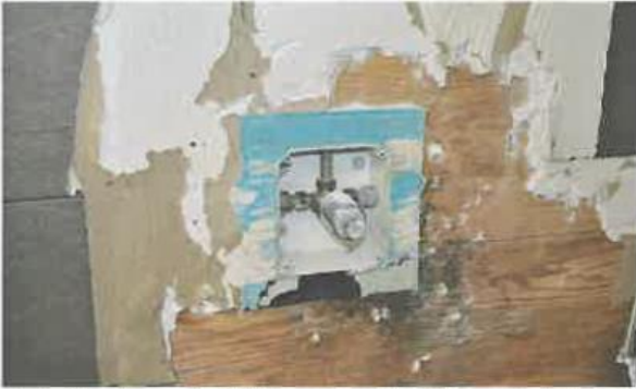
.1 Durchfeuchtung unter Abdichtungsebene Wand (Damen Dusche, Mischer an südöstlicher Außenwand, erster Mischer vom südlichen Gebäudeeck)
