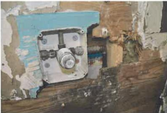
.1 Durchfeuchtung unter Abdichtungsebene Wand (Damen Dusche, Mischer an südöstlicher Außenwand, erster Mischer vom südlichen Gebäudeeck)
