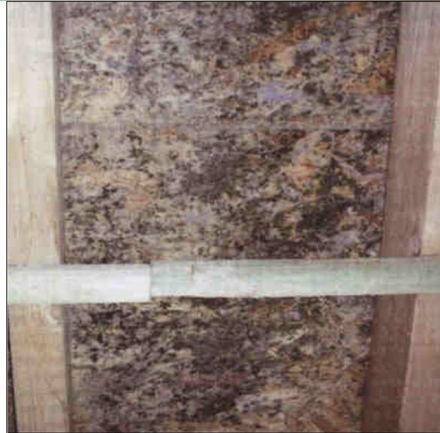
Abb. 14: Schimmelbildung auf der Unterseite der Dachschalung
