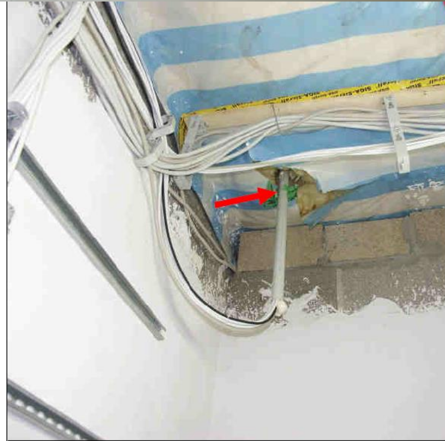
Abb. 16: Undichter Anschluss im Bereich einer Rohrdurchführung
