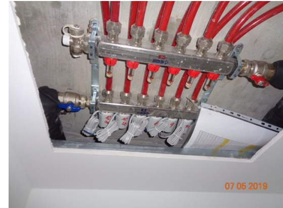
Einbau von Stellantrieben
