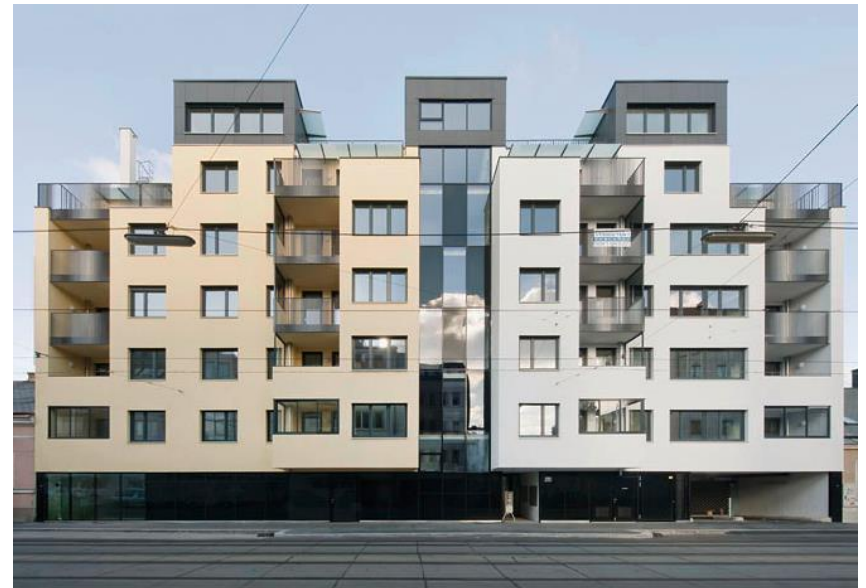
WHA 1220 Wien, Donaufelderstraße 235: WHA 1220 Wien, Donaufelderstraße 233: je 43 Wohnungen Fertigstellung 2013 und 2015
