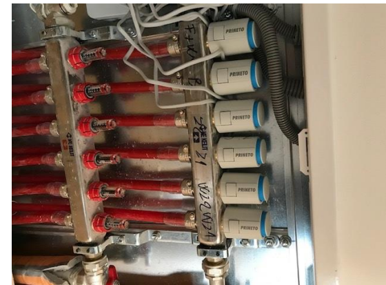
Einbau von Stellantrieben
